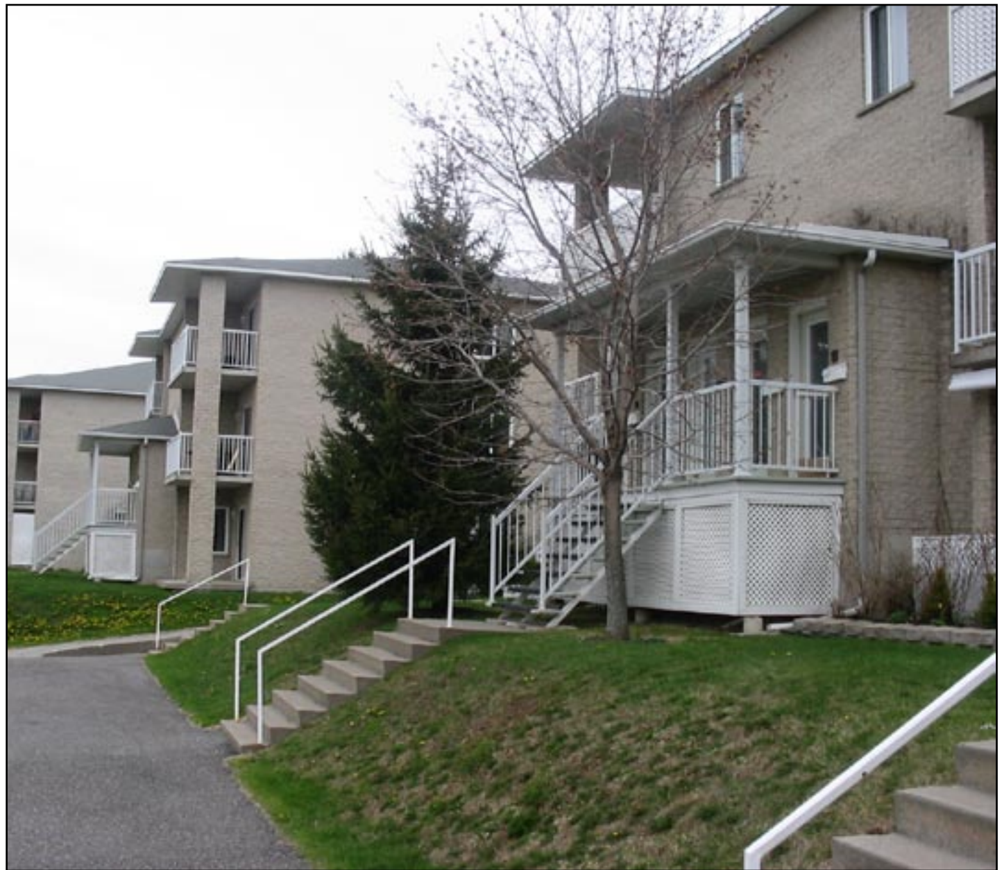
Les logements de Réal Rodrigue à Sherbrooke.
