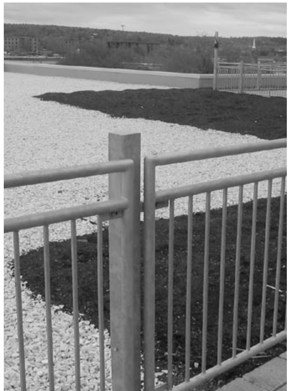
Les toits verts font de plus en plus leur apparition avec les nouvelles constructions, en exemple cette partie de toiture du Centre financier aux entreprises de Granby, projet en aménagement de verdure lors de la prise de notre photo.
