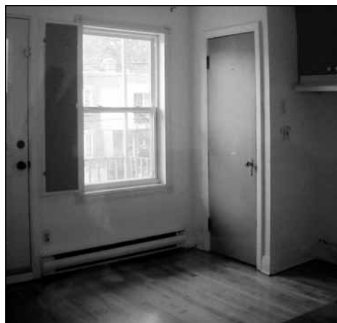
Plancher avant l'arrivée du locataire
